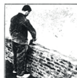
Mouvement 21 Étendre le mortier sur le mur.
