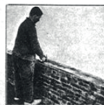
Mouvement 14 Asseoir la brique en frappant une demi-douzaine de petits coups.
