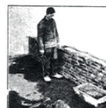
Mouvement 15 Se tourner vers l'auge.
