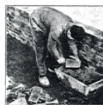
Mouvement 10 Enduire la brique de mortier.
