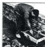
Mouvement 18 Prendre du mortier.
