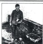
Mouvement 6 Faire sauter la brique de façon à la placer sur champ.
