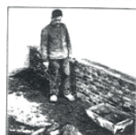
Mouvement 1 Se tourner vers le tas de briques
