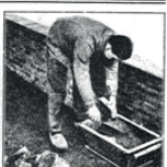
Mouvement 9 Prendre du mortier.
