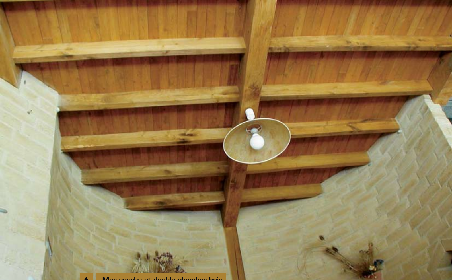
▲ Mur courbe et double plancher bois
